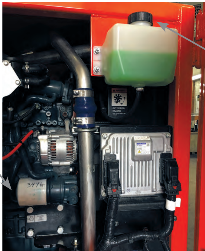
Comprobar el nivel de líquido refrigerante
